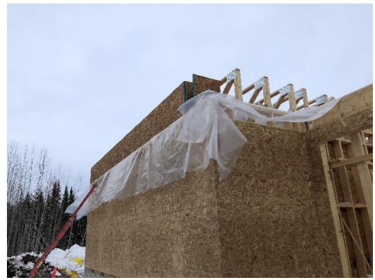
Vapour Barrier Install
