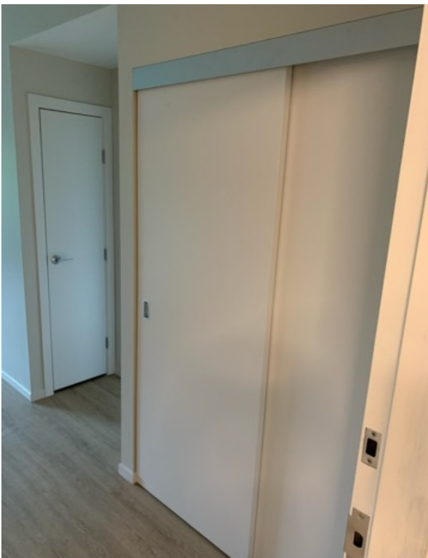
LVL 2 EW Sliding Closet Door Install
