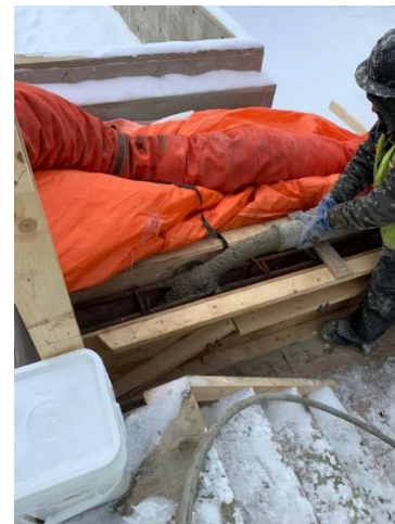
Pour concrete in center beam
