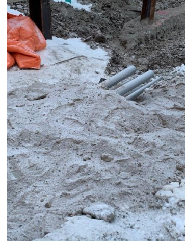
Install conduits in crawlspace
