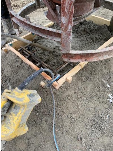
Concrete Pour – Mechanical Pads
