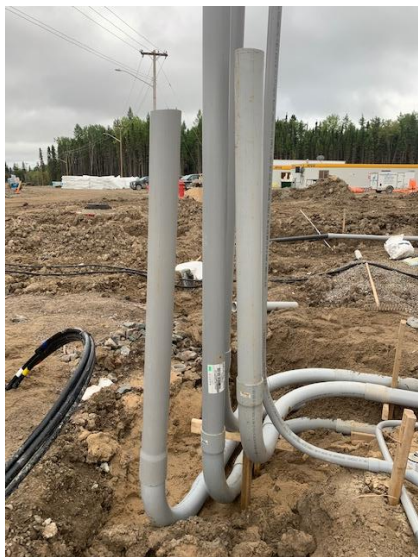
Electrical Conduits Install to CSTE
