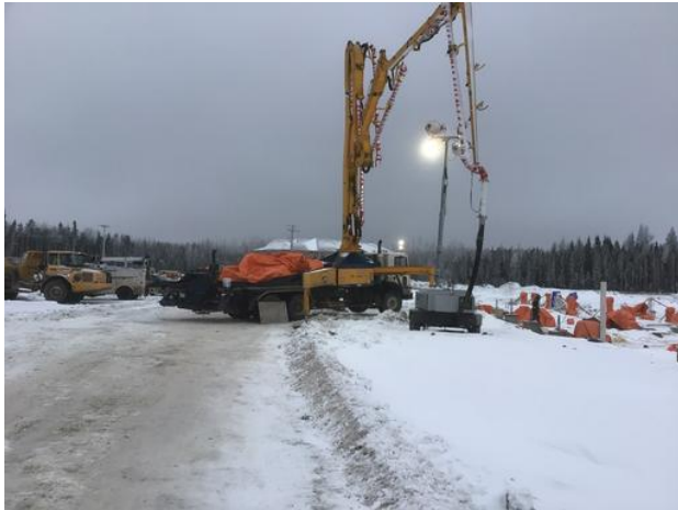
concrete line pump pour
