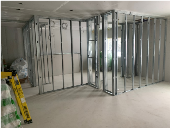
LVL 1 – 2 Bedroom Steel Stud Framing complete
