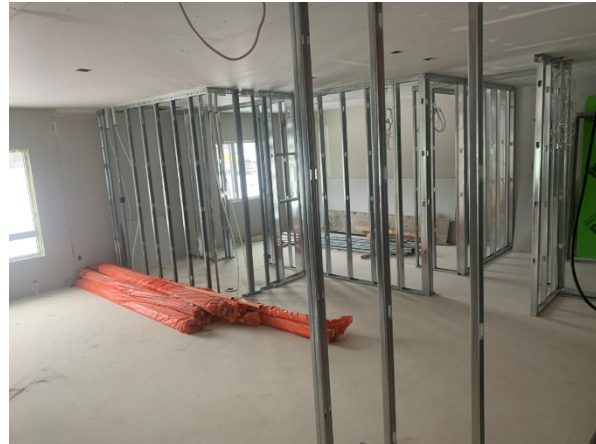
LVL 1 – 2 Bedroom Steel Stud Framing complete
