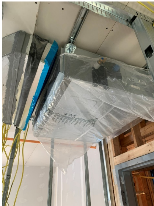
Fan Coil Install
