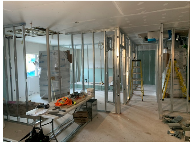
LVL 1 Steel Stud Framing
