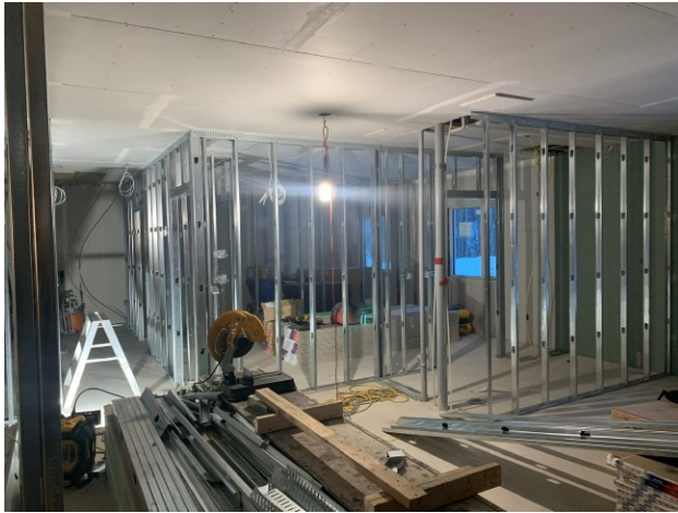
LVL 1 Steel Stud Framing
