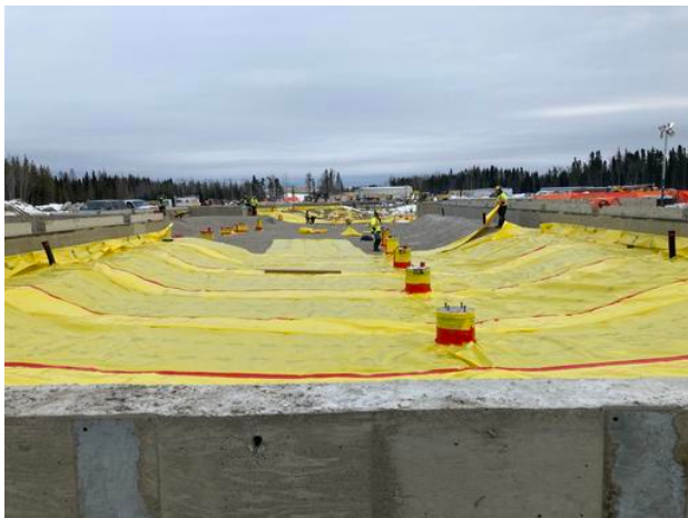
B1/B2- Poly Membrane install
