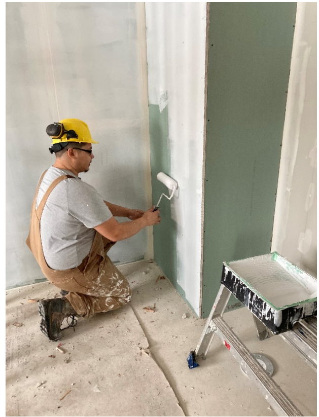
Mould Resistant Gypsum Board Primer
