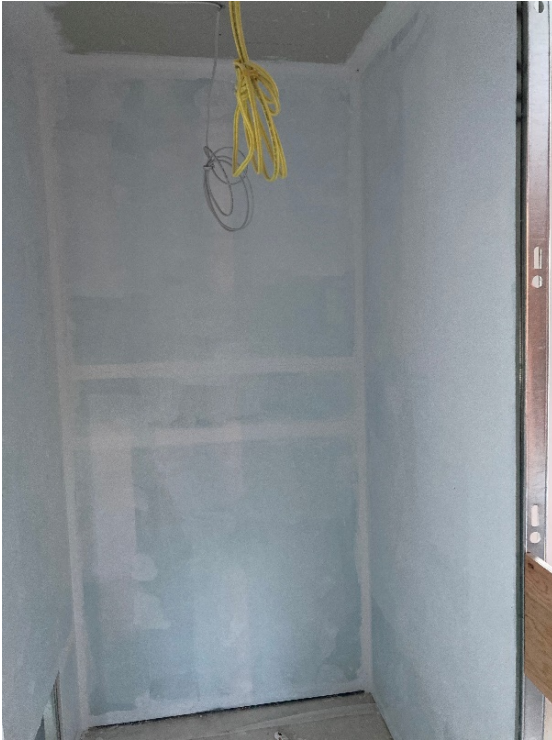
Mould Resistant Gypsum Board Primer
