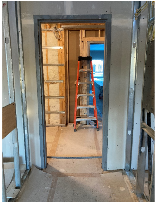
Hollow Metal Door Frame Install
