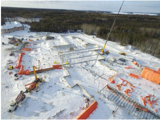
A3- Steel Erection / Concrete Pour For Grade Beam
