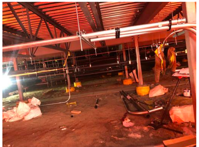
A1- Conduits Installation
