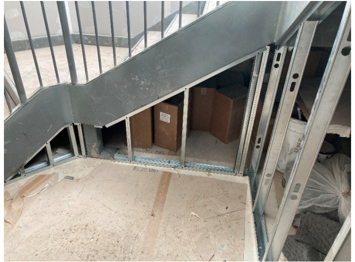
Steel Stud Framing – Stair # 1
