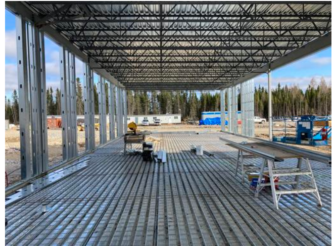
A2 steel stud framing
