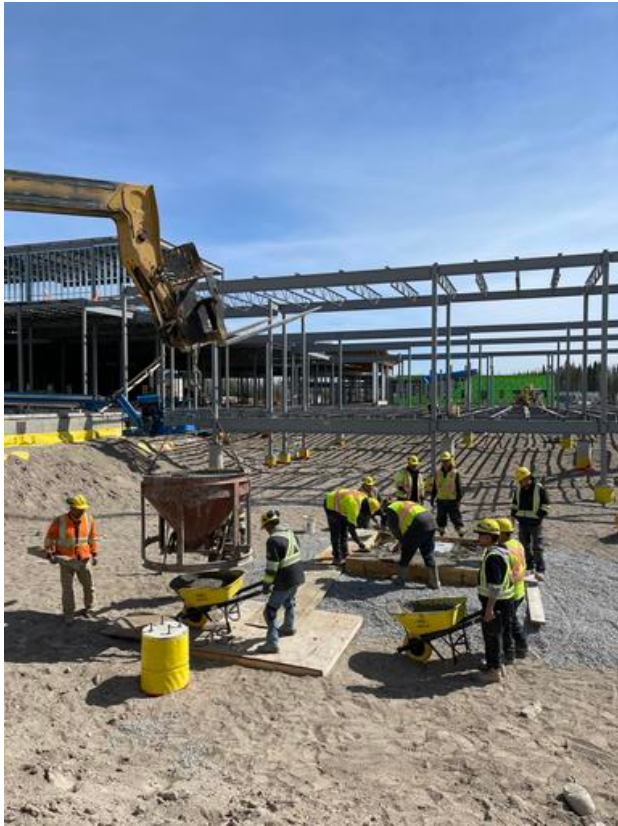
C2- Bucket pour for sump pit
