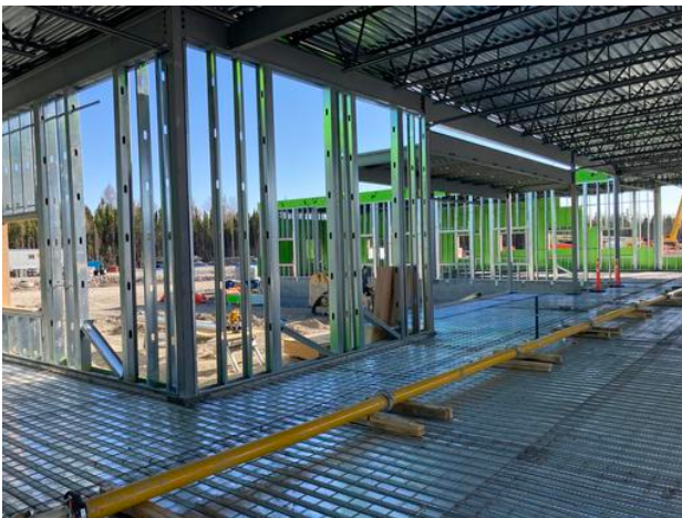
Preparing for concrete pour in A2
