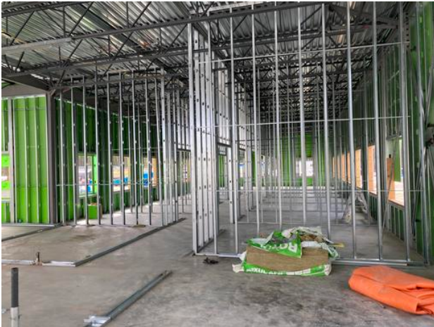
Stud framing in A2
