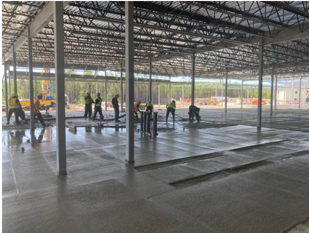
Slab pour work in progress
