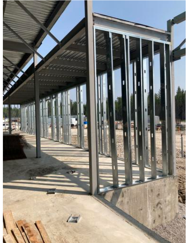
C1 exterior stud framing
