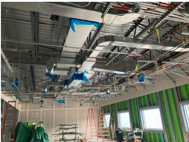
Conduit installation on -going B1
