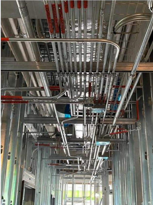
Electrical Conduit Install
