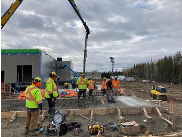
Tank farm pads slab pour on going
