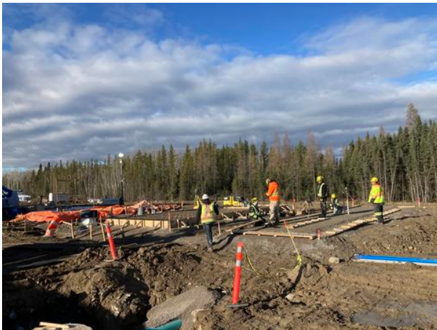
Forming around med gas pad
