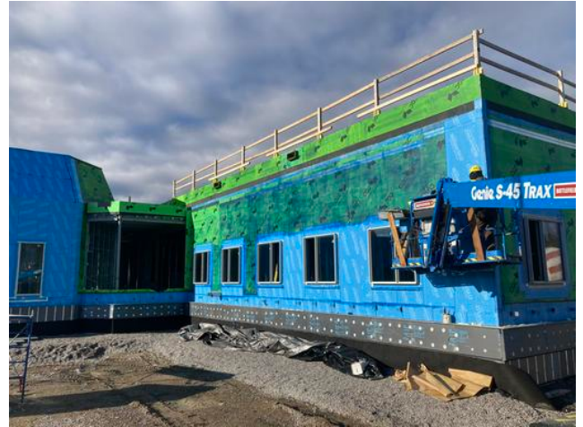
Installing AVB a1 finger
